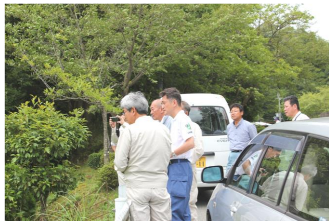
戸知山の砂防堰堤や棚田、笠脇水路の調査。7/16 台風の来襲直前に防災対策や水路の状態を調べる。 一部農道にかかる橋の老朽化などを発見！ 住民の安全を守るために常に活動しています。
