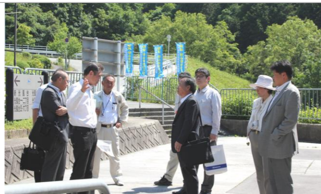
老朽化した光風台エスカレーターの現地調査 5/26 町民の足であるエスカレーター更新のための調査を実施。 9月町議会で可決されれば、実施設計。 平成28年度中に工事完成予定。
