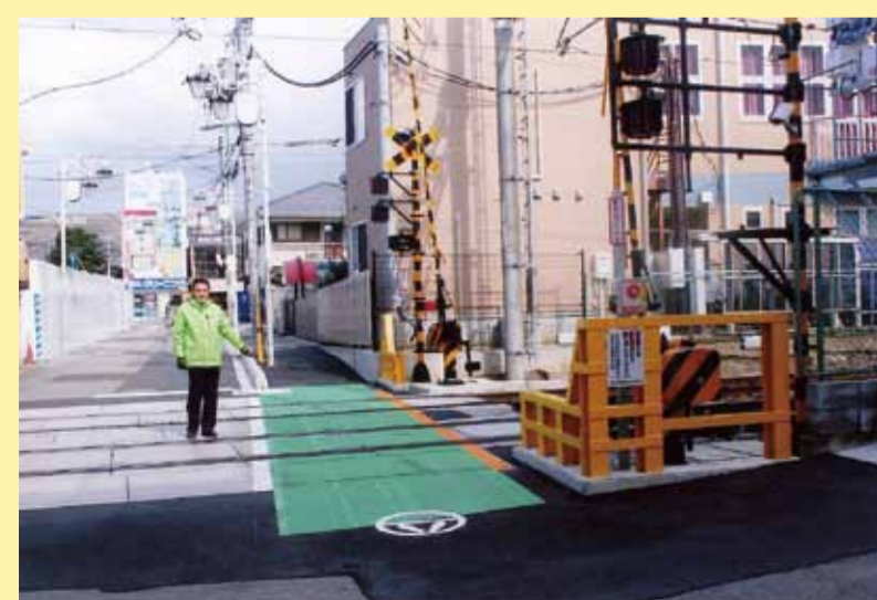
桜井停車場線 平成27年2月 踏切の拡幅が完了しました
