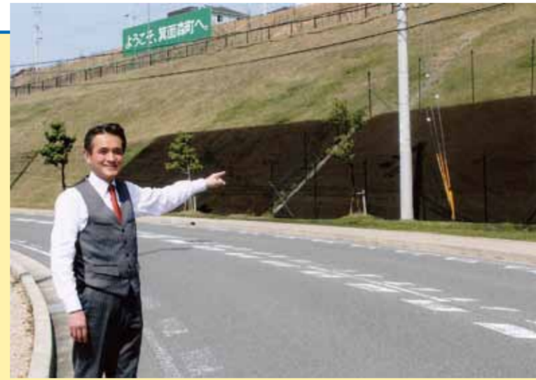
とどろみの森学園の北側法面への種子吹付
