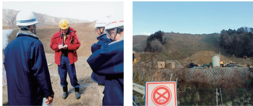
土砂崩れで府道余野茨木線は通行止め
